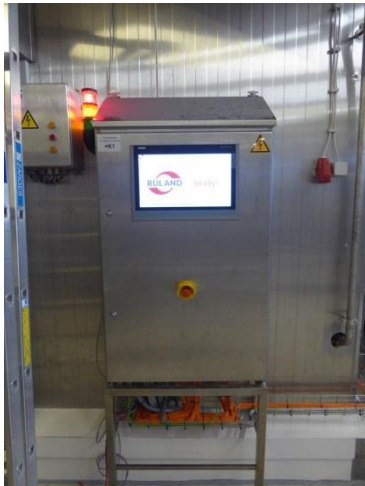
Abb. 11: VISU und Schaltschrank
